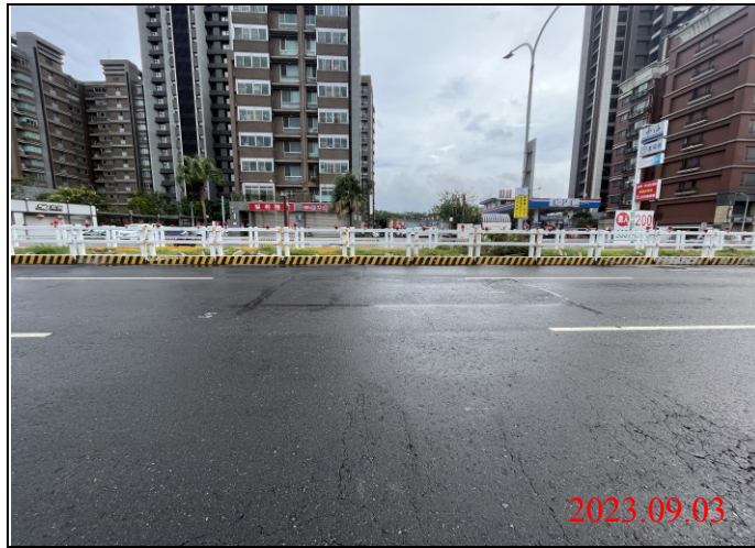
巡查日期地點：112.09.03/ Y23車站 照片說明：路面龜裂狀況
