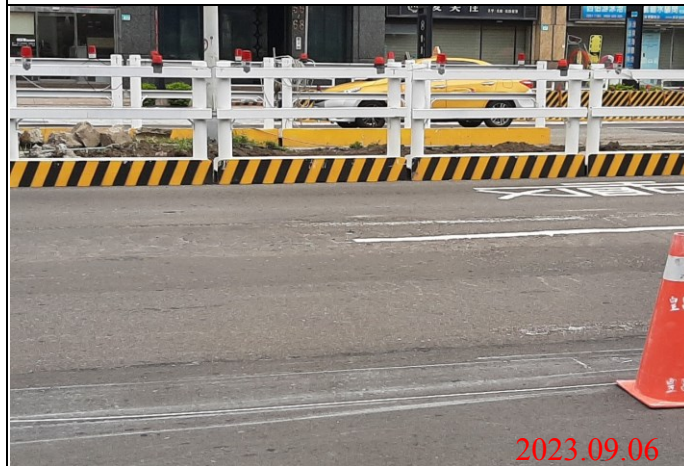
巡查日期地點：112.09.06/ Y23車站 照片說明：路面龜裂狀況
