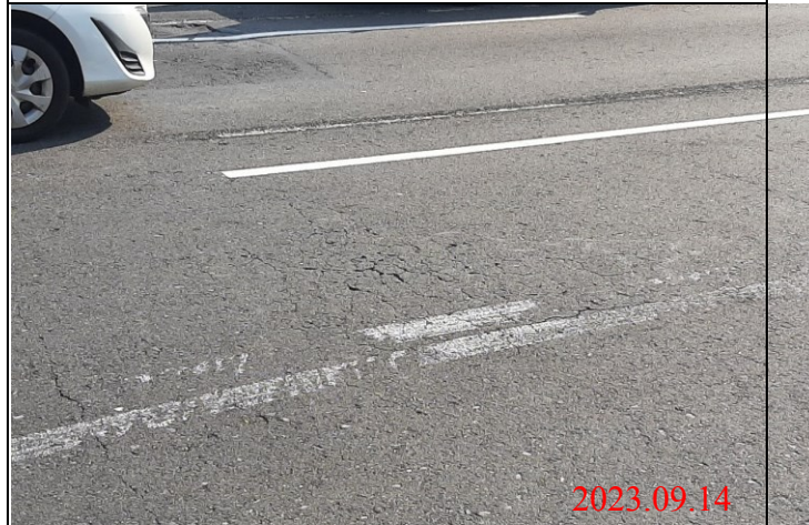
巡查日期地點：112.09.14/ Y23車站 照片說明：路面龜裂狀況
