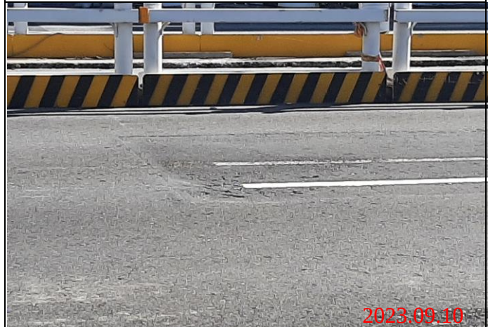
巡查日期地點：112.09.10/ Y23車站 照片說明：路面龜裂狀況
