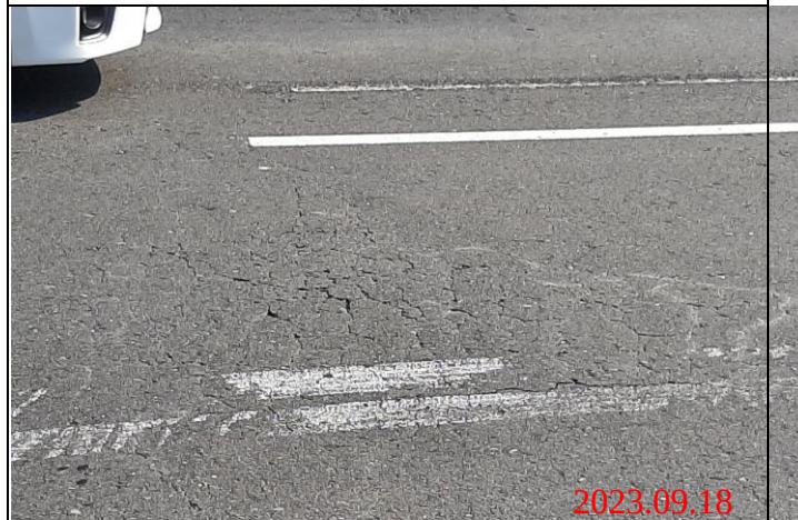
巡查日期地點：112.09.18/ Y23車站 照片說明：路面龜裂狀況
