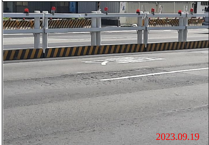
巡查日期地點：112.09.19/ Y23車站 照片說明：路面龜裂狀況
