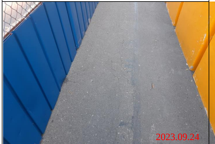
巡查日期地點：112.09.24/ Y23車站 照片說明：路面龜裂狀況
