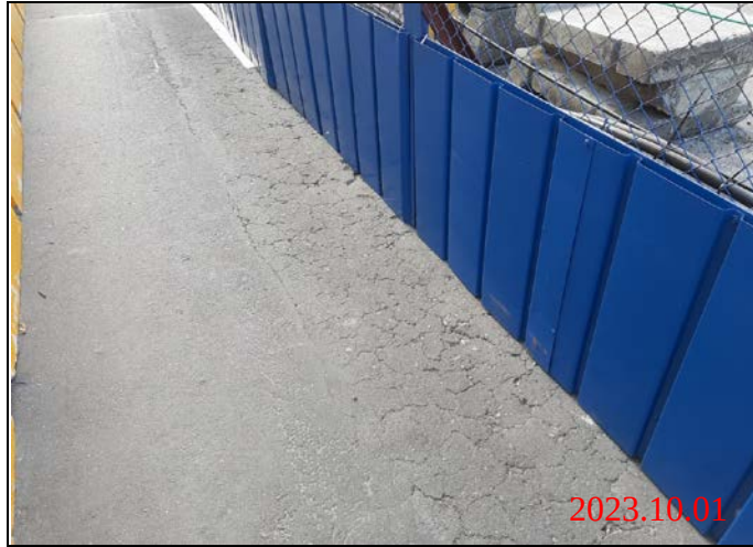
巡查日期地點：112.10.01/ Y23車站 照片說明：路面龜裂狀況
