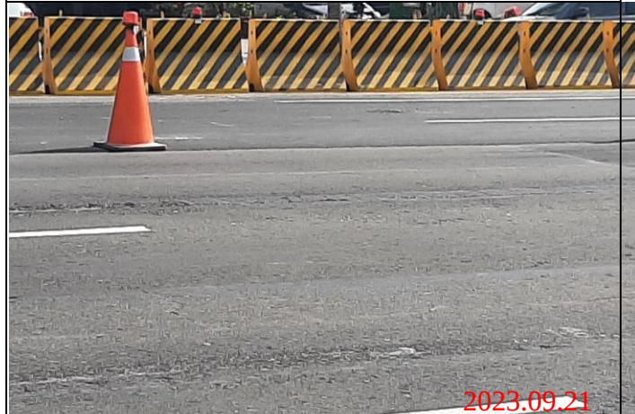
巡查日期地點：112.09.21/ Y23車站 照片說明：路面龜裂狀況
