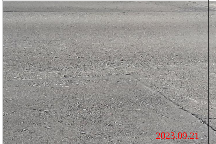
巡查日期地點：112.09.21/ Y23車站 照片說明：路面龜裂狀況
