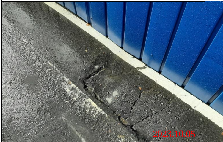
巡查日期地點：112.10.05/ Y23車站 照片說明：路面龜裂狀況
