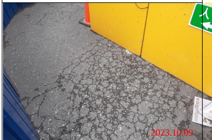
巡查日期地點：112.10.09/ Y23車站 照片說明：路面龜裂狀況
