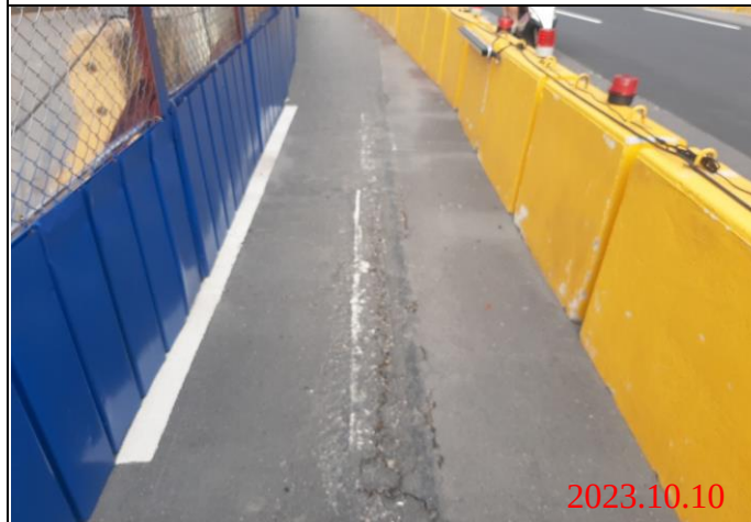
巡查日期地點：112.10.10/ Y23車站 照片說明：路面龜裂狀況
