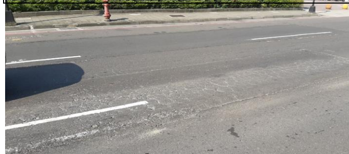
巡查日期地點：112.10.10/ Y23車站 照片說明：路面龜裂狀況
