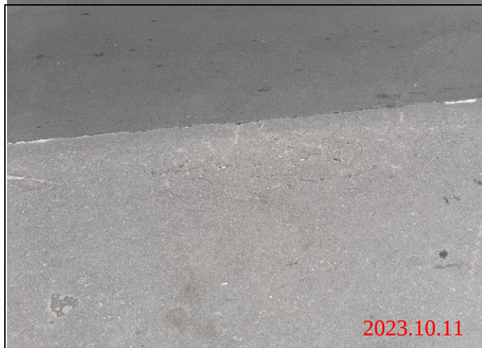
巡查日期地點：112.10.11/ Y23車站 照片說明：路面龜裂狀況
