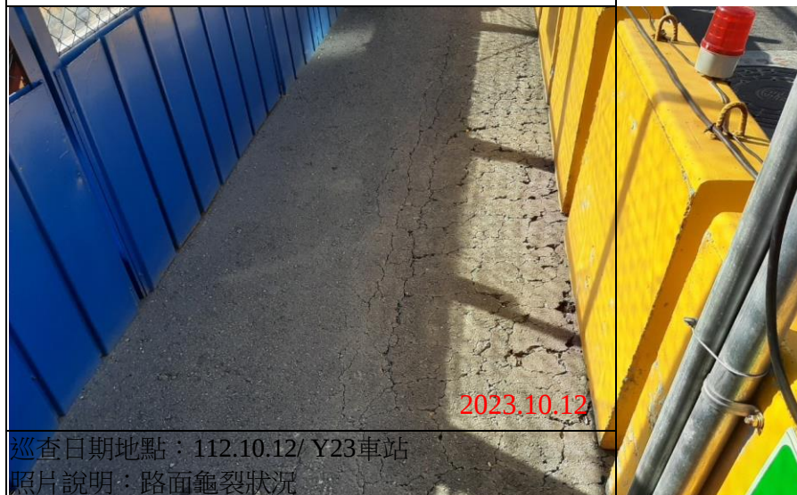
巡查日期地點：112.10.12/ Y23車站 照片說明：路面龜裂狀況
