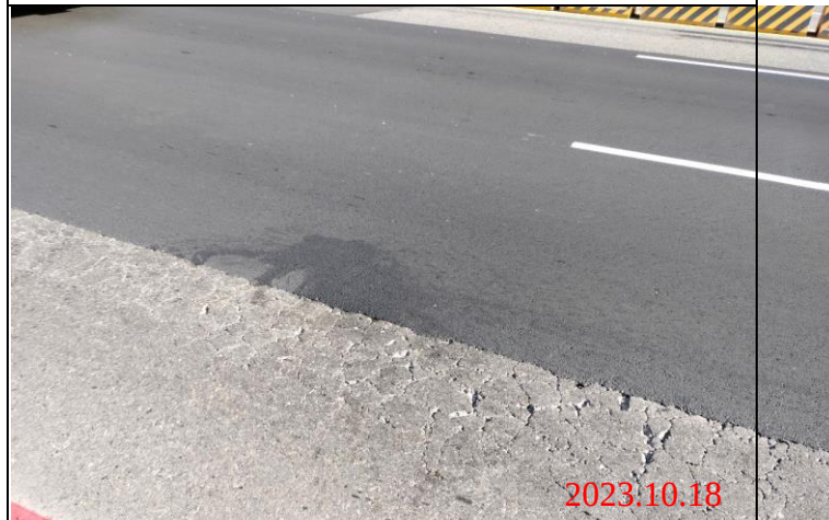
巡查日期地點：112.10.18/ Y23車站 照片說明：路面龜裂狀況
