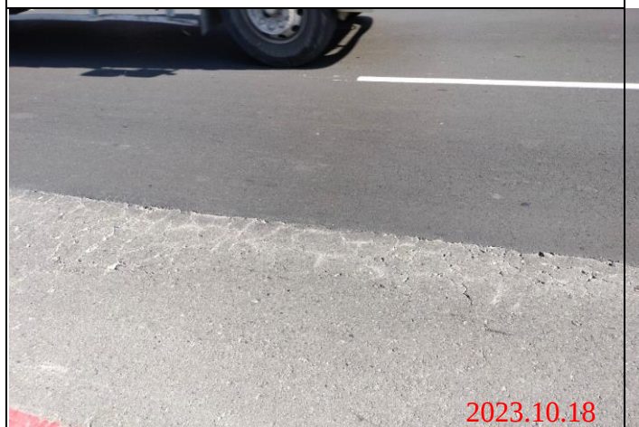
巡查日期地點：112.10.18/ Y23車站 照片說明：路面龜裂狀況
