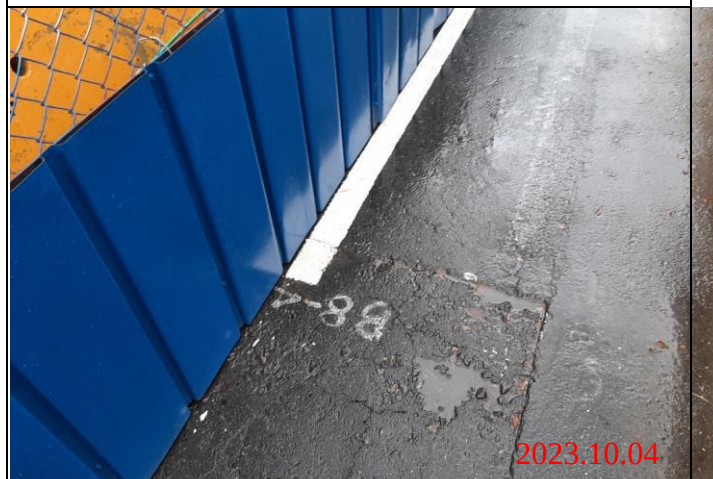
巡查日期地點：112.10.04/ Y23車站 照片說明：路面龜裂狀況
