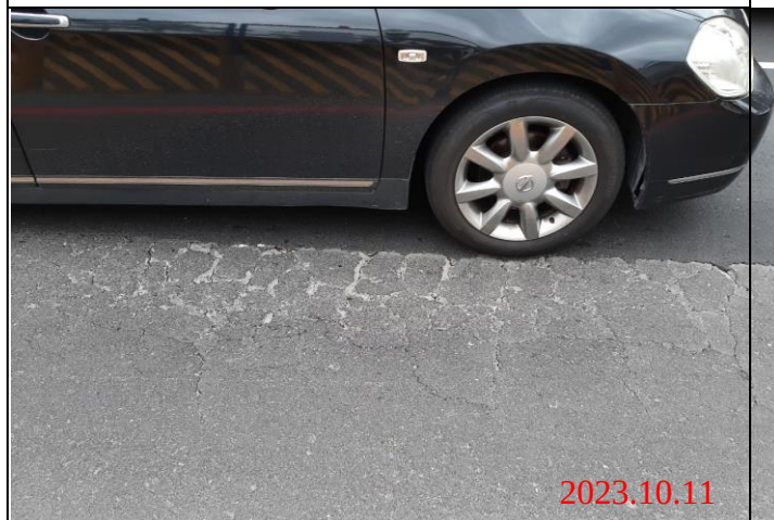
巡查日期地點：112.10.11/ Y23車站 照片說明：路面龜裂狀況
