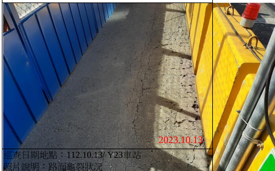
巡查日期地點：112.10.13/ Y23車站 照片說明：路面龜裂狀況
