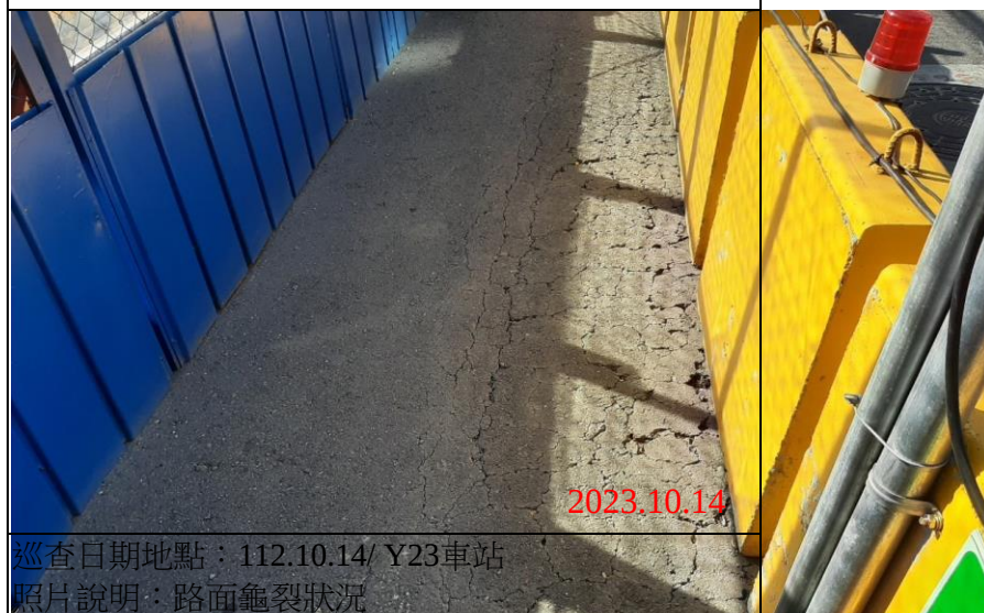
巡查日期地點：112.10.14/ Y23車站 照片說明：路面龜裂狀況
