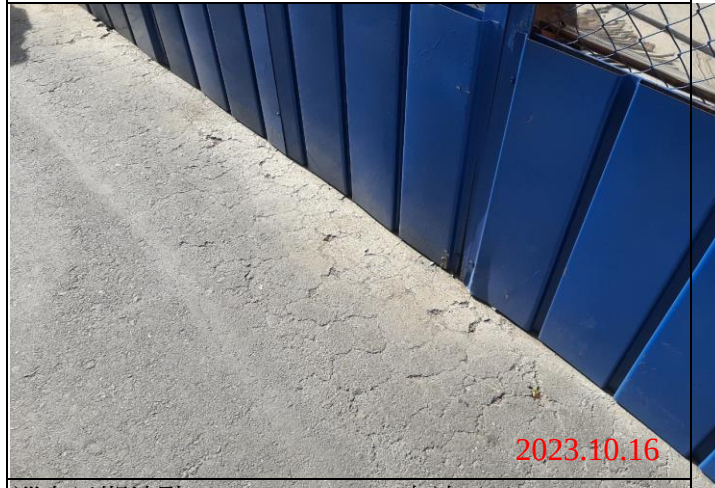
巡查日期地點：112.10.16/ Y23車站 照片說明：路面龜裂狀況
