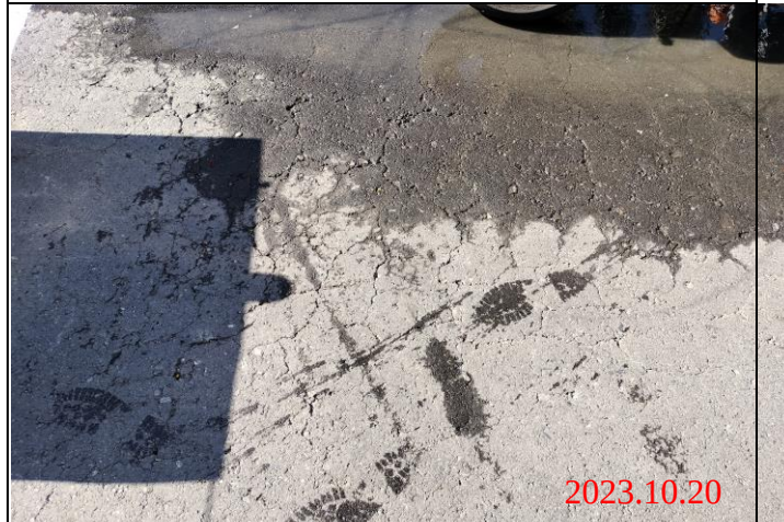
巡查日期地點：112.10.20/ Y23車站 照片說明：路面龜裂狀況
