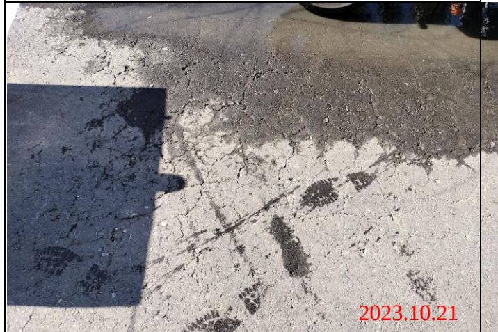
巡查日期地點：112.10.21/ Y23車站 照片說明：路面龜裂狀況
