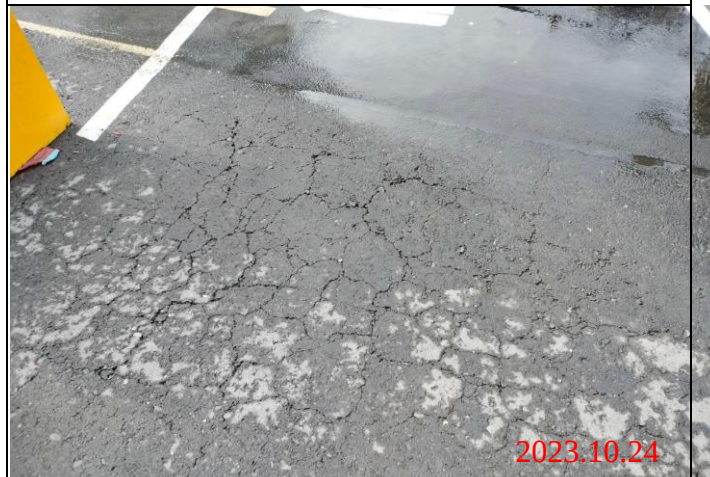
巡查日期地點：112.10.24/ Y23車站 照片說明：路面龜裂狀況
