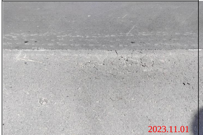
巡查日期地點：112.11.01/ Y23車站 照片說明：路面龜裂狀況
