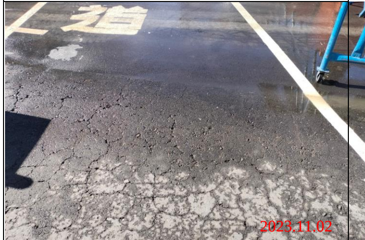
巡查日期地點：112.11.02/ Y23車站 照片說明：路面龜裂狀況
