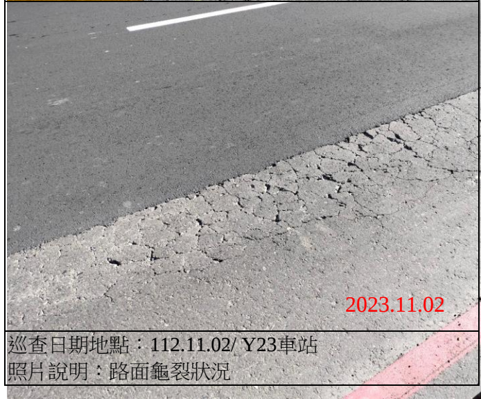
巡查日期地點：112.11.02/ Y23車站 照片說明：路面龜裂狀況
