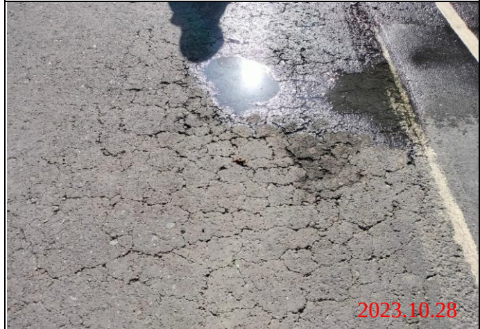
巡查日期地點：112.10.28/ Y23車站 照片說明：路面龜裂狀況
