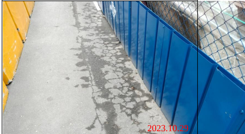
巡查日期地點：112.10.29/ Y23車站 照片說明：路面龜裂狀況
