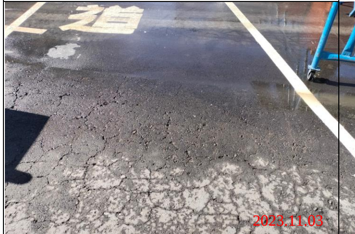
巡查日期地點：112.11.03/ Y23車站 照片說明：路面龜裂狀況
