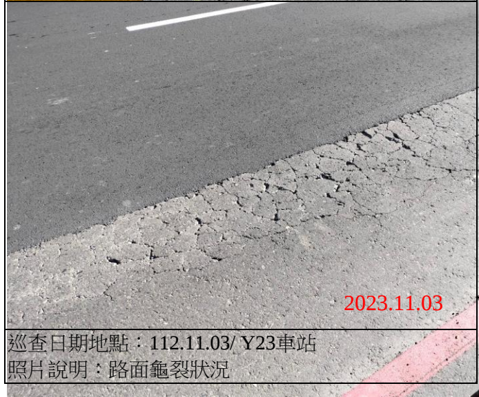
巡查日期地點：112.11.03/ Y23車站 照片說明：路面龜裂狀況
