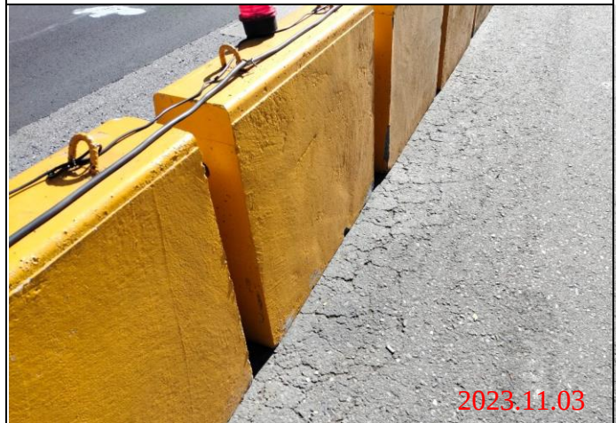
巡查日期地點：112.11.03/ Y23車站 照片說明：路面龜裂狀況
