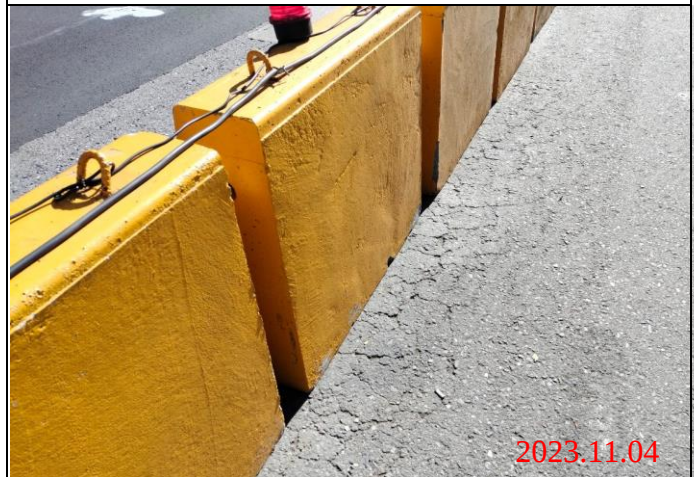
巡查日期地點：112.11.04/ Y23車站 照片說明：路面龜裂狀況
