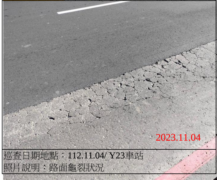
巡查日期地點：112.11.04/ Y23車站 照片說明：路面龜裂狀況
