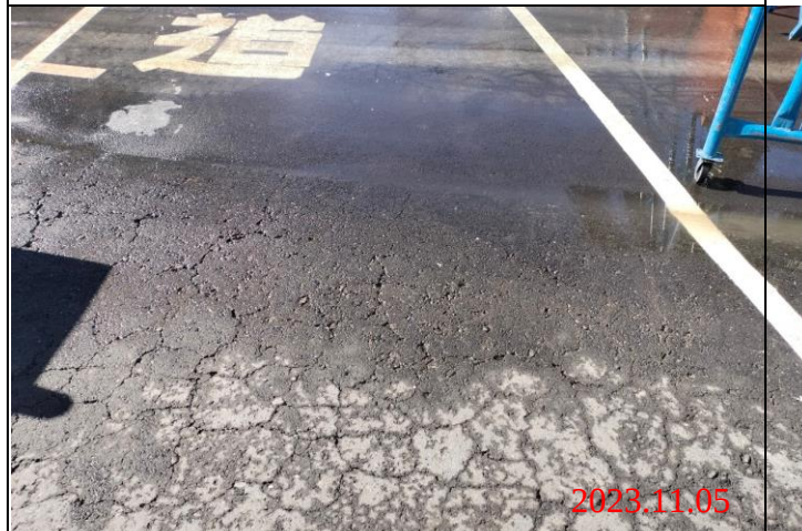
巡查日期地點：112.11.05/ Y23車站 照片說明：路面龜裂狀況
