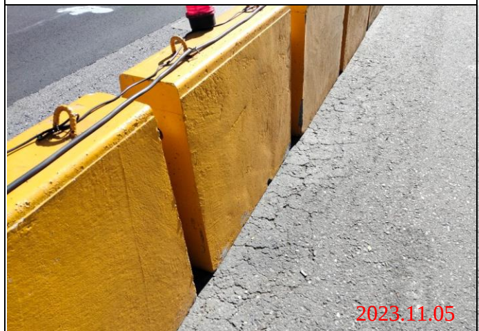
巡查日期地點：112.11.05/ Y23車站 照片說明：路面龜裂狀況
