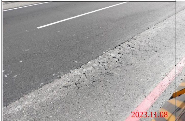
巡查日期地點：112.11.08/ Y23車站 照片說明：路面龜裂狀況
