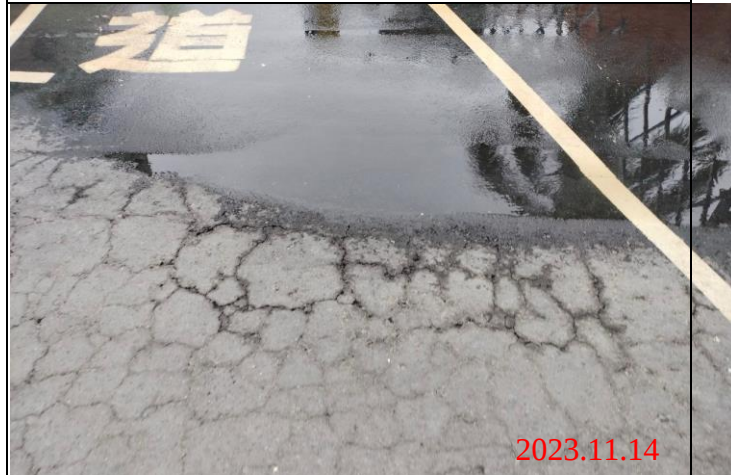
巡查日期地點：112.11.14/ Y23車站 照片說明：路面龜裂狀況
