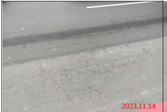
巡查日期地點：112.11.14/ Y23車站 照片說明：路面龜裂狀況
