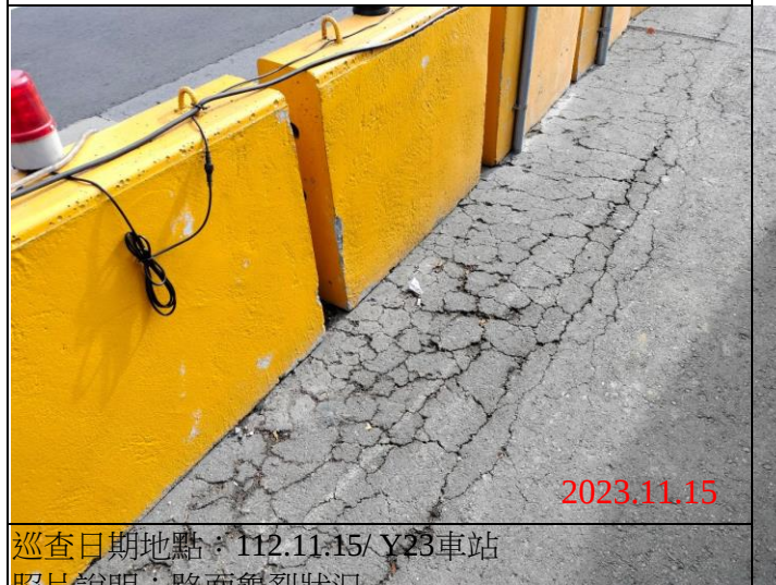
巡查日期地點：112.11.15/ Y23車站 照片說明：路面龜裂狀況
