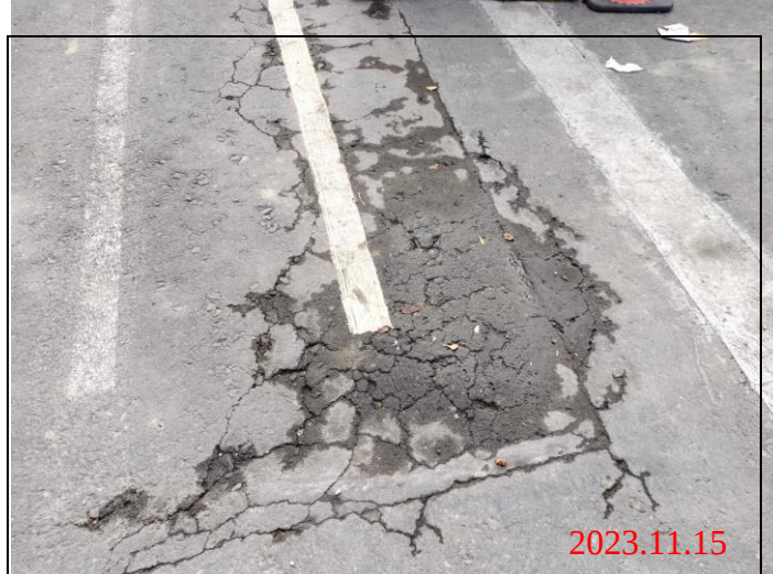
巡查日期地點：112.11.15/ Y23車站 照片說明：路面龜裂狀況
