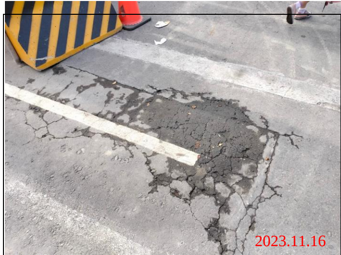
巡查日期地點：112.11.16/ Y23車站 照片說明：路面龜裂狀況
