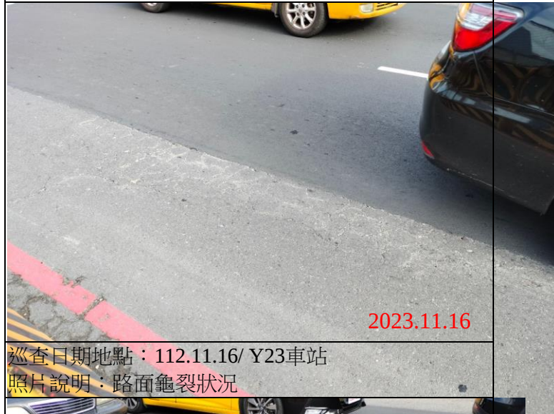
巡查日期地點：112.11.16/ Y23車站 照片說明：路面龜裂狀況
