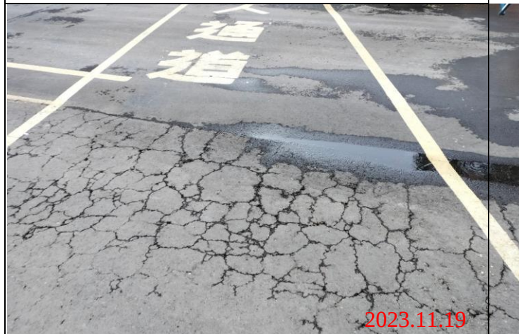
巡查日期地點：112.11.19/ Y23車站 照片說明：路面龜裂狀況
