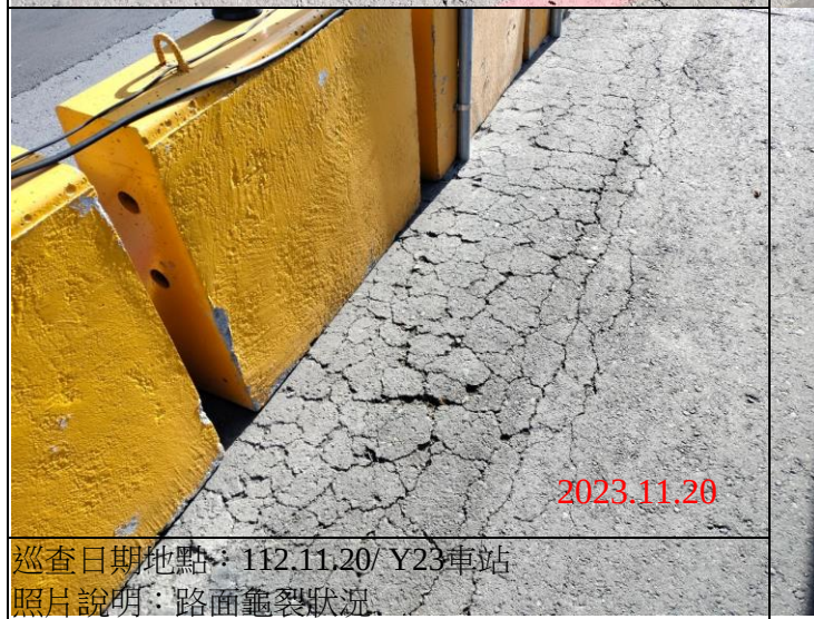
巡查日期地點：112.11.20/ Y23車站 照片說明：路面龜裂狀況
