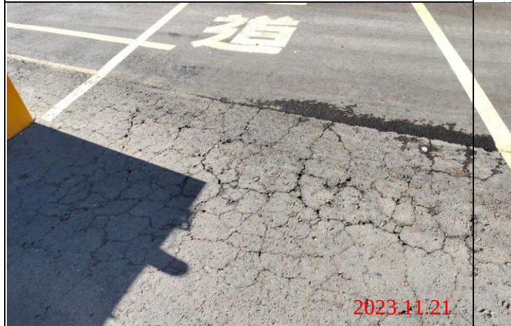
巡查日期地點：112.11.21/ Y23車站 照片說明：路面龜裂狀況
