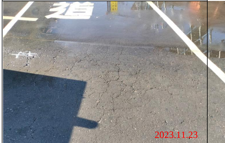
巡查日期地點：112.11.23/ Y23車站 照片說明：路面龜裂狀況
