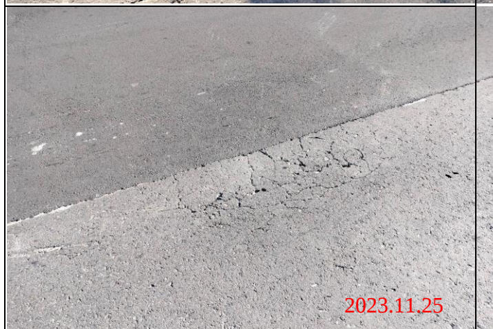
巡查日期地點：112.11.25/ Y23車站 照片說明：路面龜裂狀況
