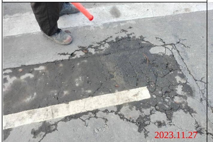
巡查日期地點：112.11.27/ Y23車站 照片說明：路面龜裂狀況
