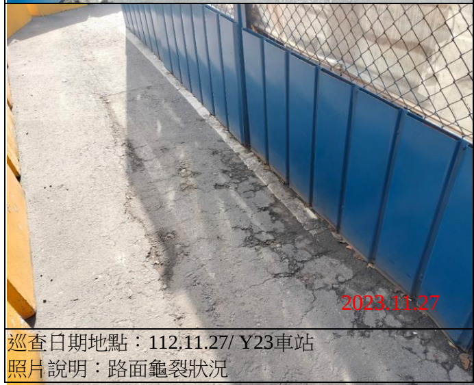
巡查日期地點：112.11.27/ Y23車站 照片說明：路面龜裂狀況
