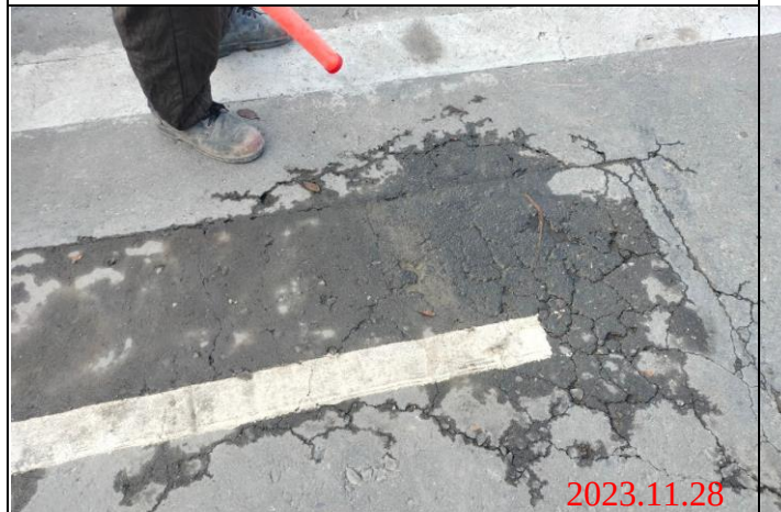
巡查日期地點：112.11.28/ Y23車站 照片說明：路面龜裂狀況
