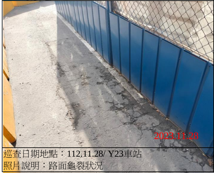
巡查日期地點：112.11.28/ Y23車站 照片說明：路面龜裂狀況
