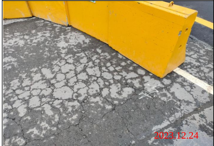
巡查日期地點：112.12.24/ Y23車站 照片說明：路面龜裂狀況
