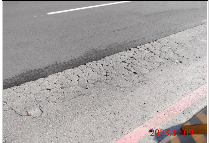
巡查日期地點：112.12.09/ Y23車站 照片說明：路面龜裂狀況
