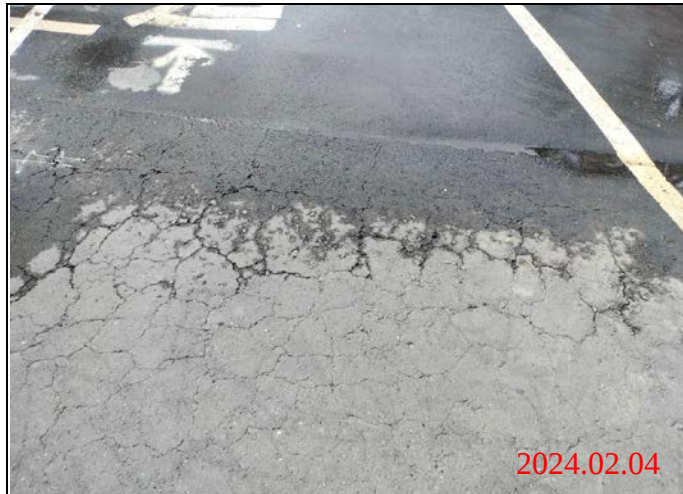
巡查日期地點：113.02.04/ Y23車站 照片說明：路面龜裂狀況
