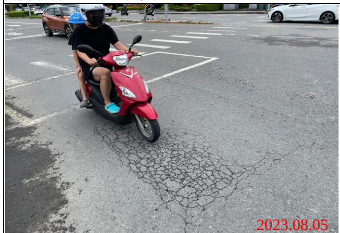
巡查日期地點：112.08.05/ Y22車站 照片說明：路面龜裂狀況
