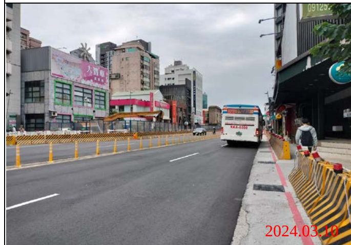
巡查日期地點：113.03.10/ Y21車站 照片說明：路面狀況
