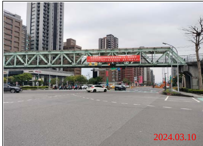
巡查日期地點：113.03.10/ Y23車站 照片說明：路面狀況
