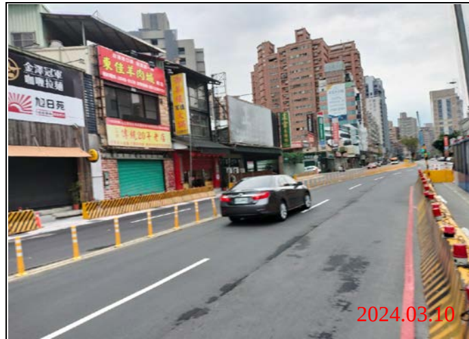
巡查日期地點：113.03.10/ Y21車站 照片說明：路面狀況
