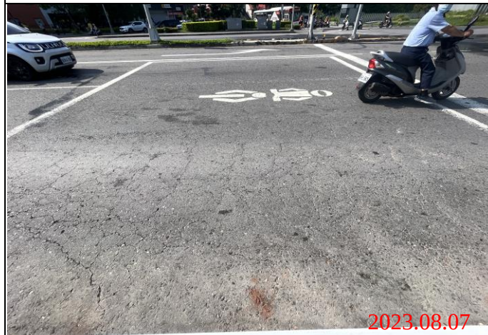
巡查日期地點：112.08.07/ Y22車站 照片說明：路面龜裂狀況
