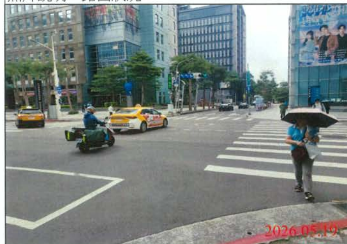
巡查日期地點：115.05.19/ Y31車站 照片說明：路面狀況
