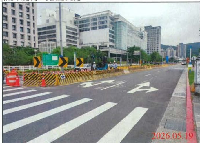
巡查日期地點：115.05.19/ 尾軌 照片說明：路面狀況
