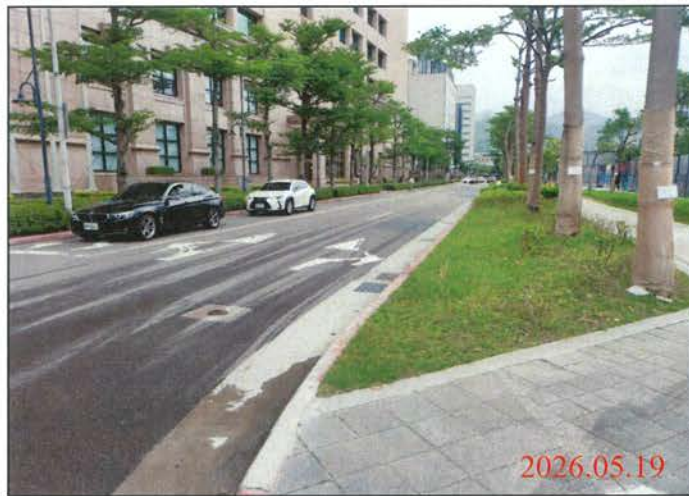
巡查日期地點：115.05.19/ Y32車站 照片說明：路面狀況
