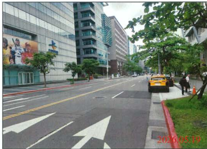
巡查日期地點：115.05.19/ Y31車站 照片說明：路面狀況
