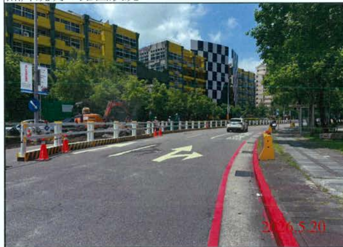
巡查日期地點：115.05.20/ Y30車站 照片說明：路面狀況
