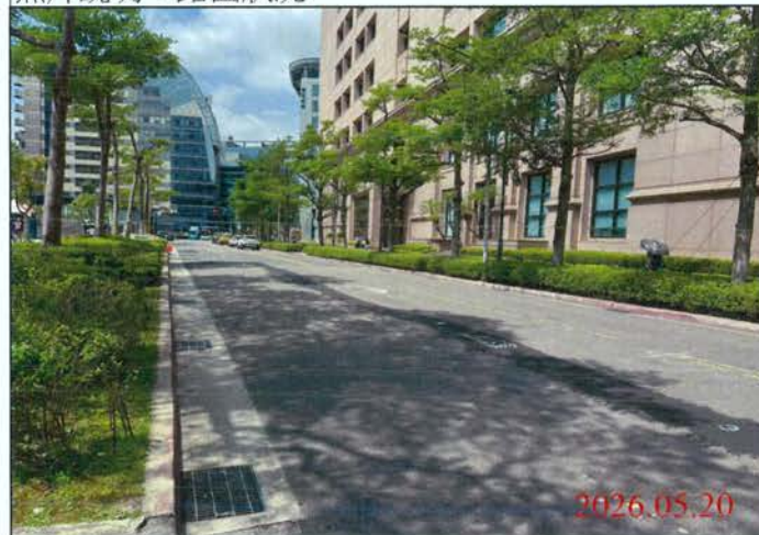
巡查日期地點：115.05.20/ Y32車站 照片說明：路面狀況
