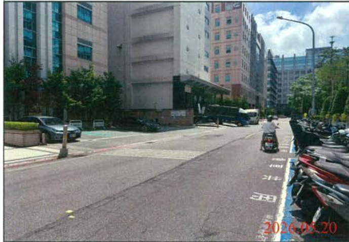
巡查日期地點：115.05.20/ Y31車站 照片說明：路面狀況
