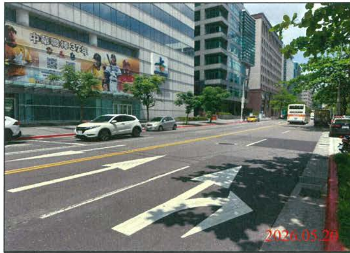
巡查日期地點：115.05.20/ Y31車站 照片說明：路面狀況
