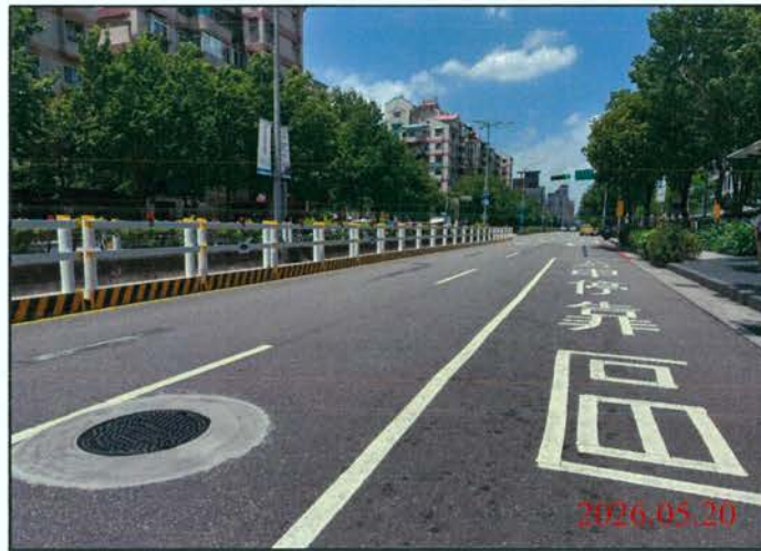
巡查日期地點：115.05.20/ Y30車站 照片說明：路面狀況
