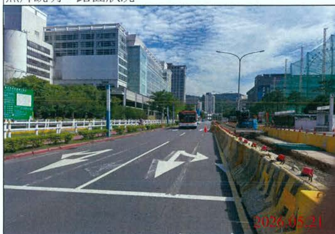
巡查日期地點：115.05.21/ 尾軌 照片說明：路面狀況
