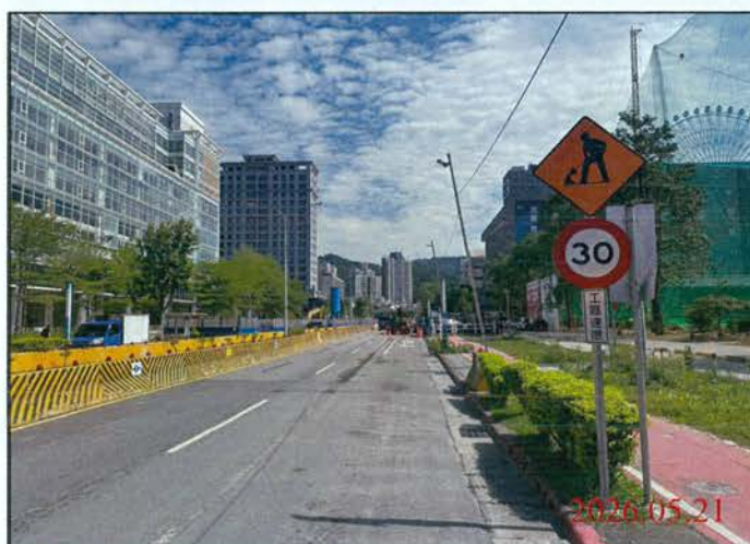
巡查日期地點：115.05.21/ 尾軌 照片說明：路面狀況
